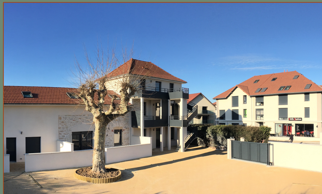
« Le Clos Vulpi » La Verpillière Réhabilitation d'une ancienne bâtisse et création de 6 logements
